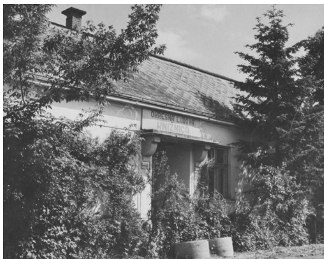
Okresná ľudová knižnica na Štefánikovej ulici
